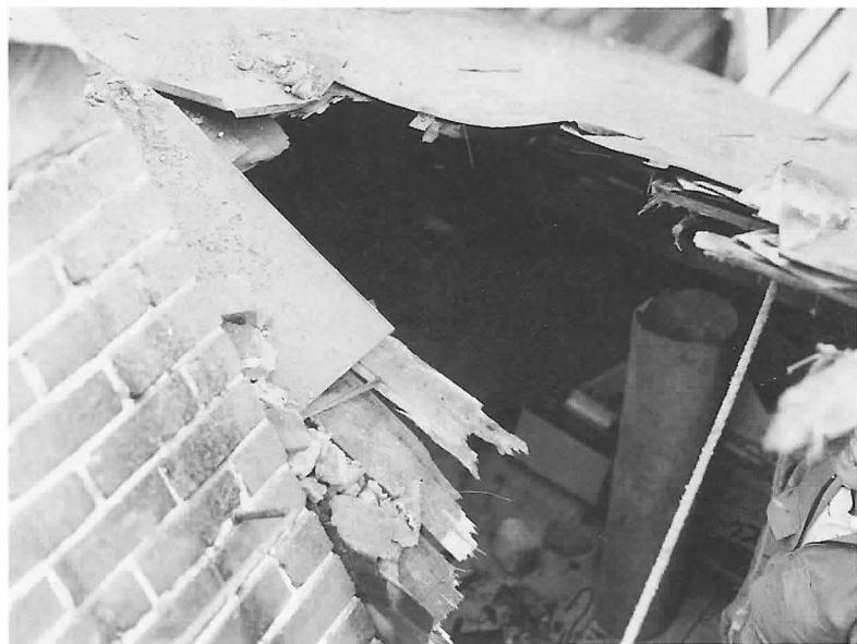
写真7 集合煙突の折損による屋根破壊（北竜町）
