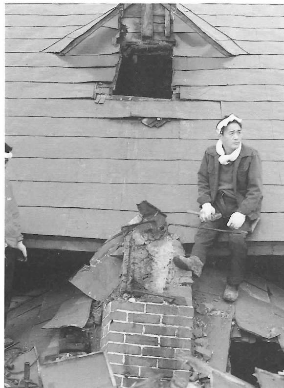
写真6 集合煙突の折損による屋根破壊（北竜町）
