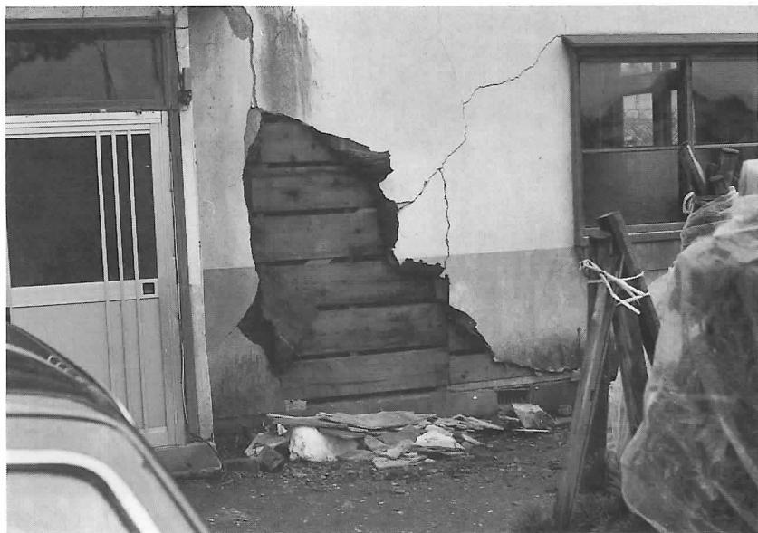
写真3 壁のひび割れ・剥離（沼田町）
