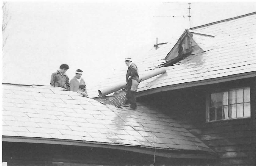
写真5 集合煙突の折損（北竜町）
