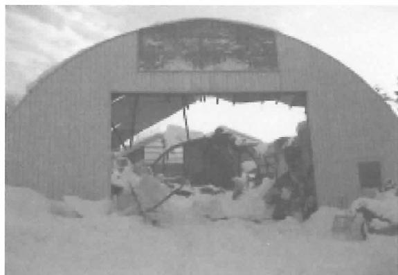
写真 5. 屋根が抜け落ちたD型ハウス
