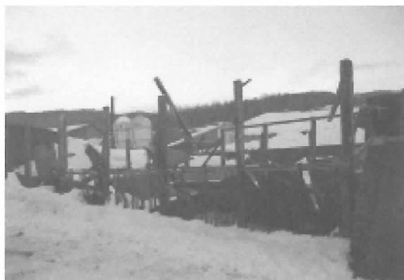
写真 6. 崩壊した牛舎
