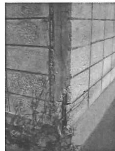
ひびが入って、鉄筋が見えているブロック塀がありました。地震による倒壊を防ぐためにも、補強が望まれます（⑭）。
