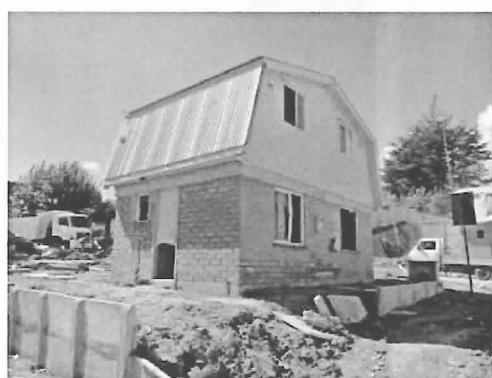
写真 3.34.1 建物外観 (1階れんが組積造, 2階木造)
