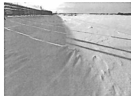
図13. 湧別町道道の防雪柵風上側の雪面.
