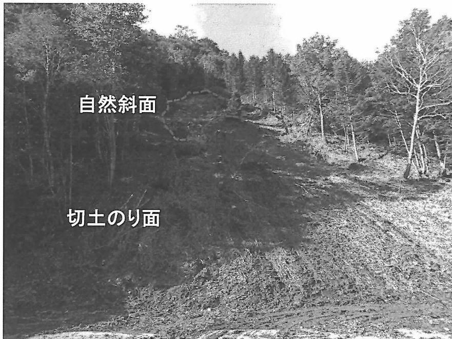
図 43 KP92.9km 付近の表層崩壊（破線による囲みは自然斜面の崩壊範囲を示す）
