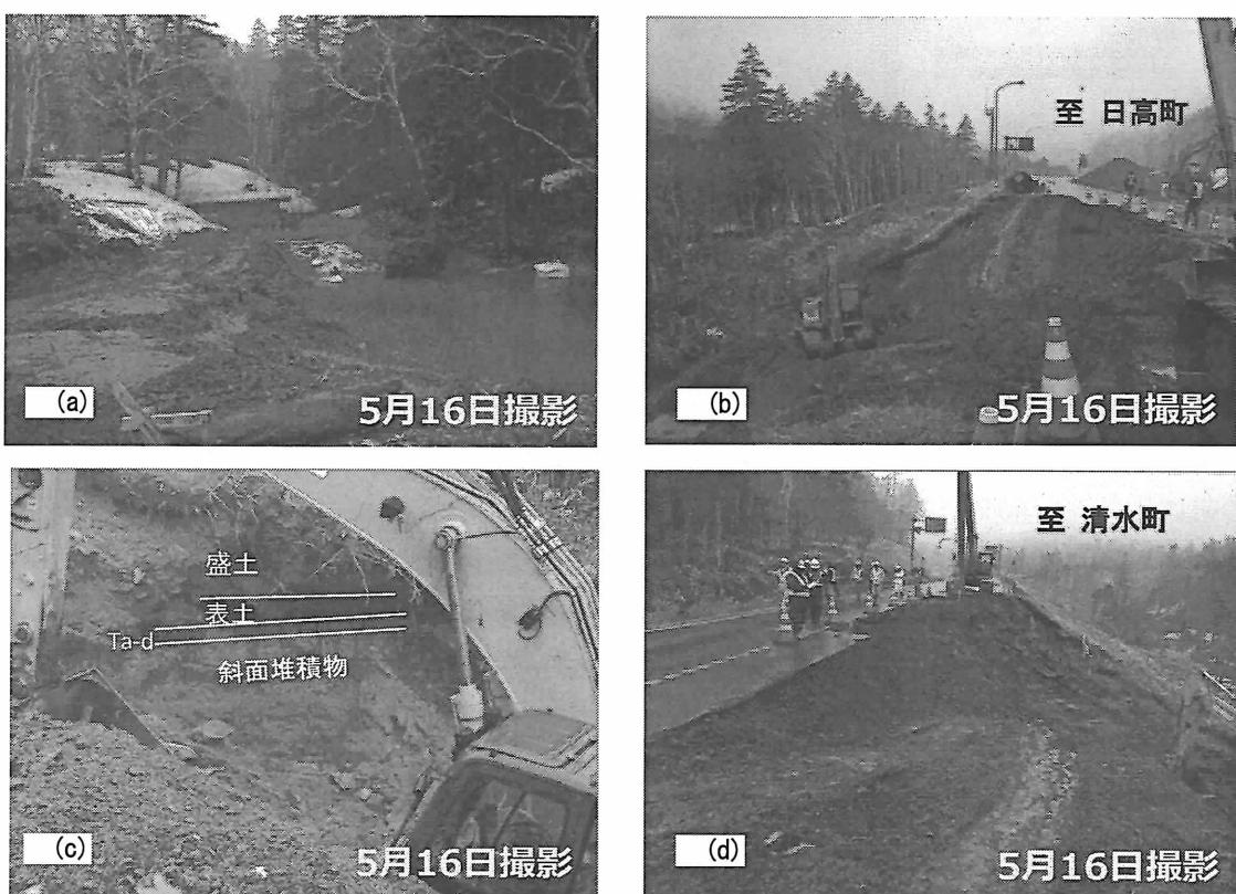
図 19 No.27 付近の盛土崩壊状況 : (a)山側沢部の状況 (b)盛土崩壊状況 (c)崩壊断面 (d)盛土崩壊状況
