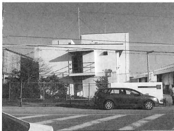
写真1 液状化により傾いた建物
