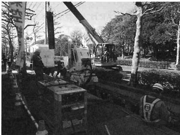
写真 3 千葉市美浜区の地下水位低下工法における外周鋼矢板（図 11(b)の止水壁）の施工状況（千葉市提供）
