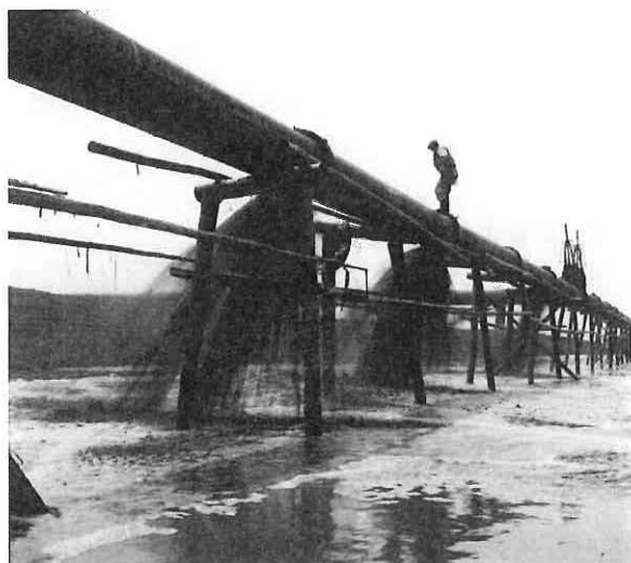
写真2 浚渫による埋立の様子 (写真提供：磯辺街づくり研究会)
