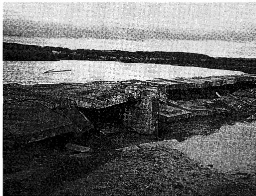
写真-II. 11 河口左岸護岸被災状況（沙流川）
