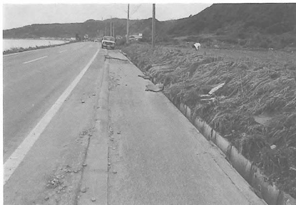
写真10 道路から引き剥されたアスファルトと道路上に散乱する礫
