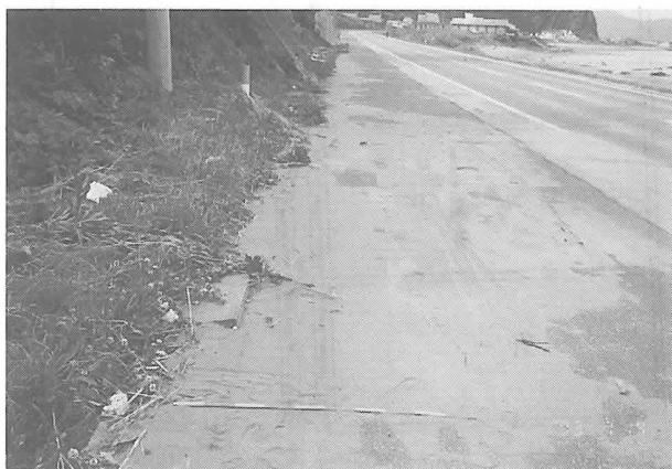
写真9 歩道上に断続的に堆積した砂
